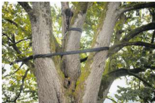
Um den danebenliegenden Gaden zu schützen, montierte Ramsauer eine Kronsicherung.
